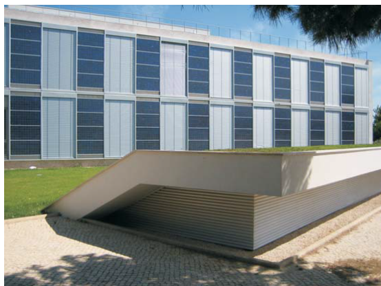
Aspecto exterior do poço de admissão de ar com grelha contínua
