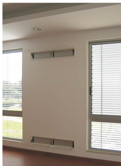
Aspecto dos orifícios de ventilação interior
