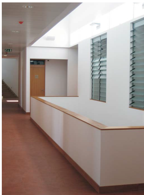
Corredor de distribuição e vãos interiores translúcidos de lâminas reguláveis
